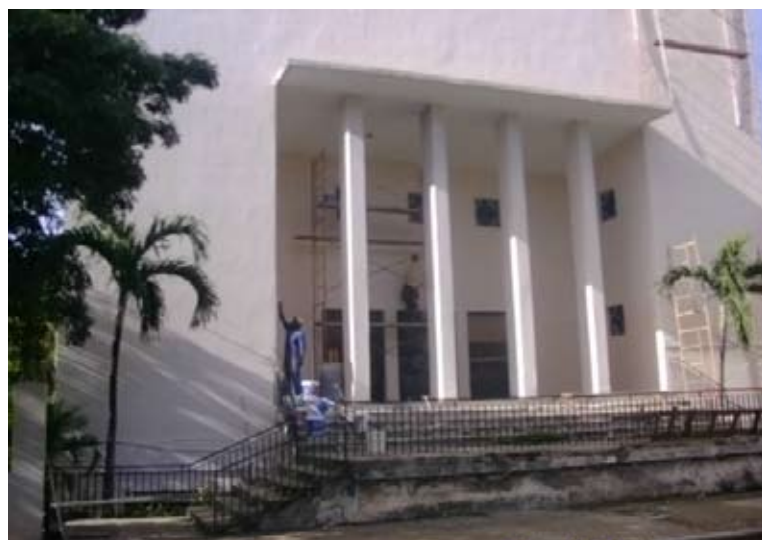
Реконструкция входа в сефардского еврейского центра в Гаване.
